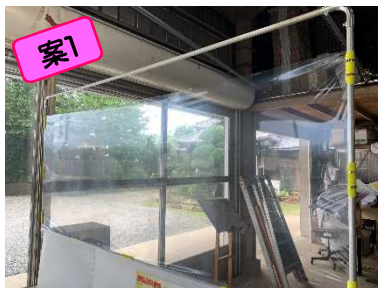
パイプで作成した枠にパッカーでビニールを取り付けて作成
